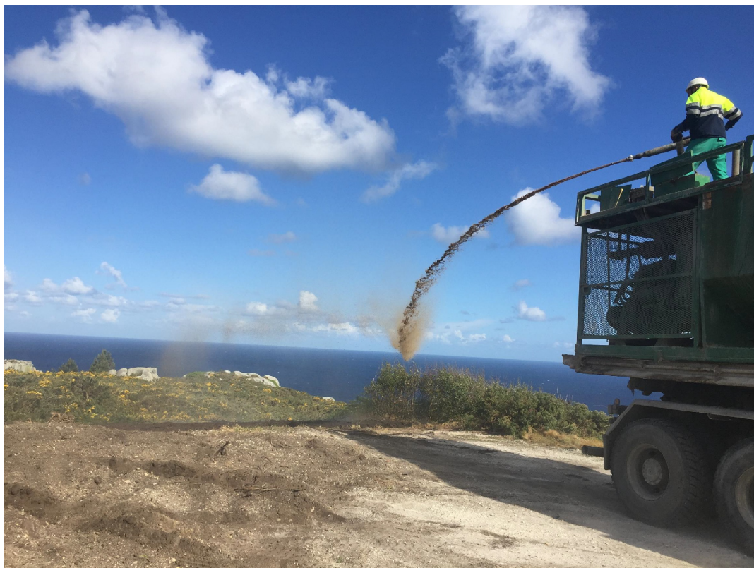
Recuperación de las plataformas mediante hidrovegetación
